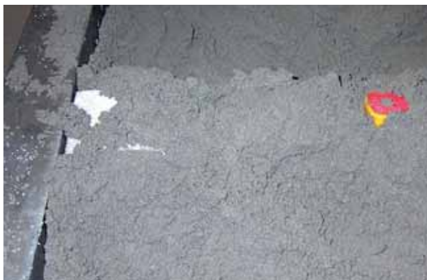
Figur 34. Letklinkerbetonelement under produktion. Forhøjning med indbygget FUGA 1M dåse, rør og udsparring. Efterfølgende udlægges den resterende letklinkerbeton, som afrettes og komprimeres.
