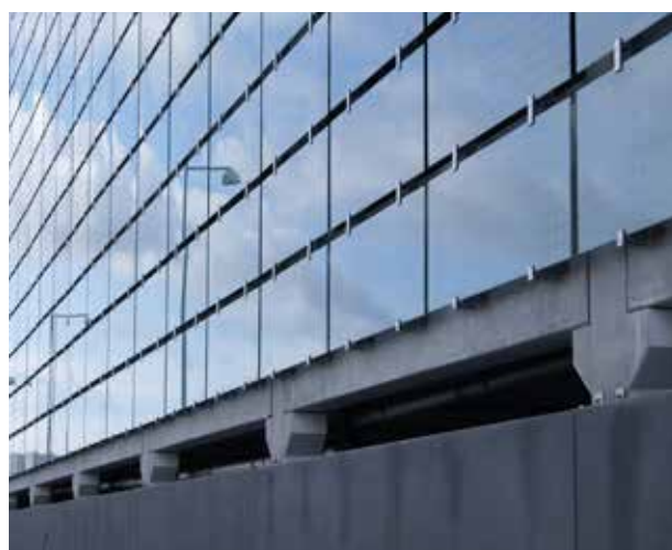
P-hus CPH Lufthavn 1.200 parkeringspladser Vi leverer også p-hus-system til Danmarks største p-hus på 2.475 pladser, som står færdig i lufthavnen i 2021.
