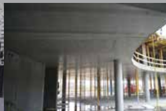
Dækkene udføres uden bærende bjælker og kan etableres med udkragede ender.
