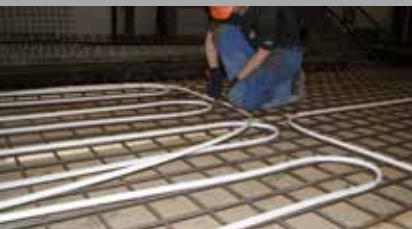
Installationer som el, afløb, køle-/varmeslanger og ventilationsrør indstøbes på fabrikken under kontrollerede forhold.
