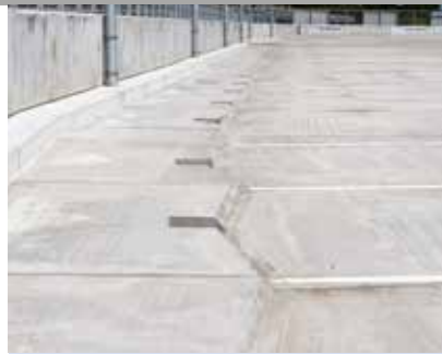
Indstøbt afvanding sikrer, at der ikke kommer vand over elastiske fuger.
