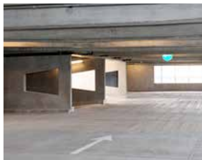
Lys og luft ved op- og nedkørsel.
