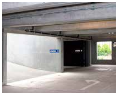
Opkørselsrampe med S-formet længdeprofil.
