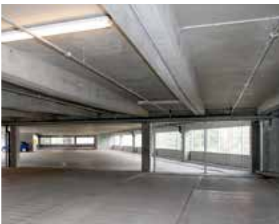
2,5 m afstand mellem sprinklerinstallationer - 1 stk. mellem hver ribbe.
