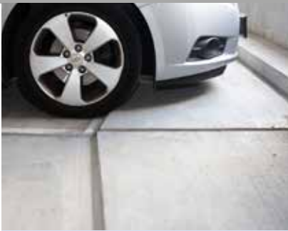
Fortovsbump vejleder bilisterne til ikke at ramme P-husets væg ved parkering.
