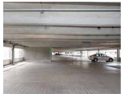
Ingen søjler som bilisterne skal parkere udenom. Ribbekonstruktionen giver stort luftvolumen.
